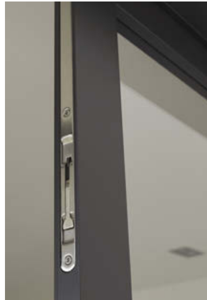
Stehflügel mit verlängertem Kantenriegel
