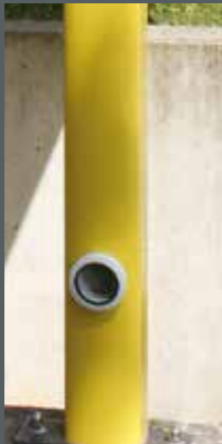
Entwässerung durch Stütze
